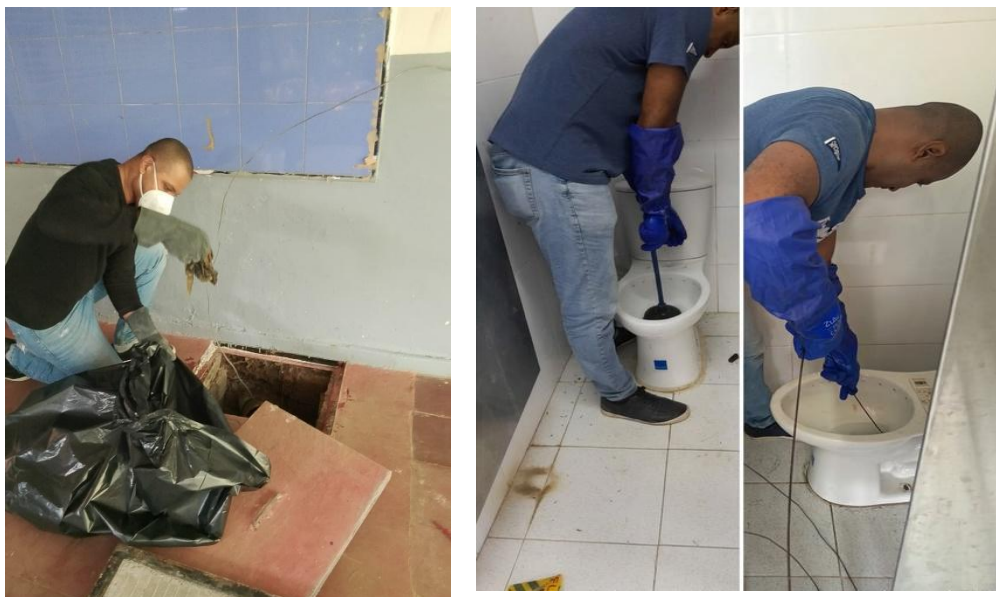
Destape mantenimiento de cajas de aguas residuales e inodoros
