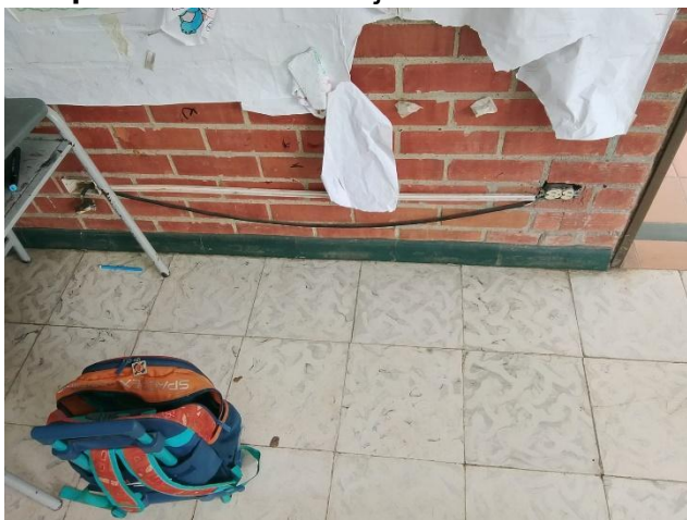
Cambio y mejoramiento de tomas sala de sistemas john f Kennedy
