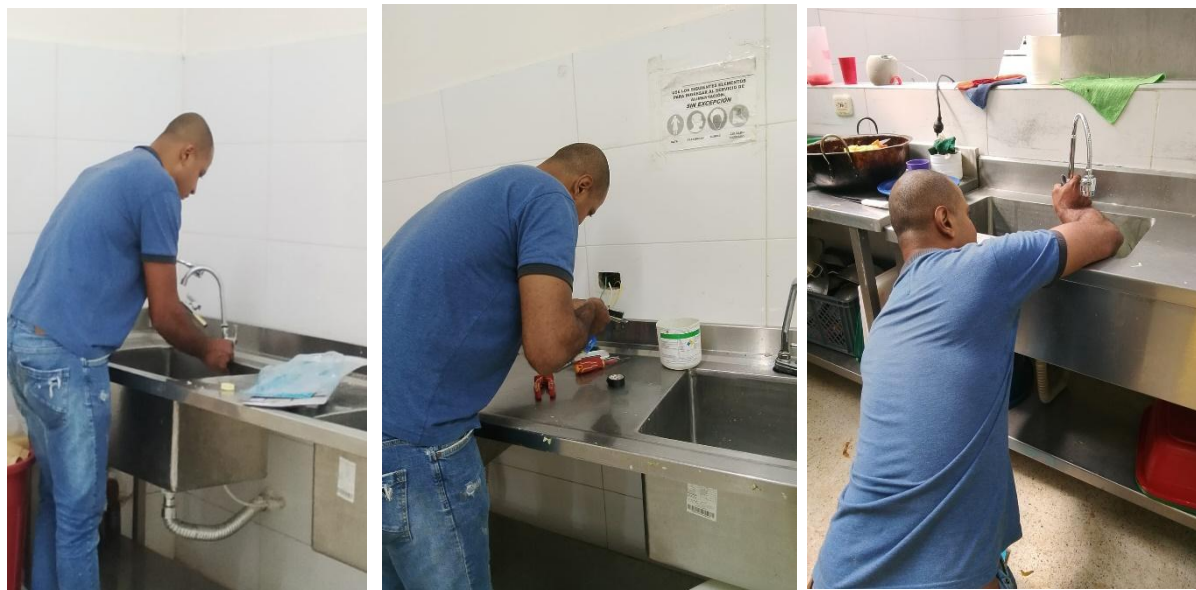
Cambio y reparación de grifos en todas las sedes
