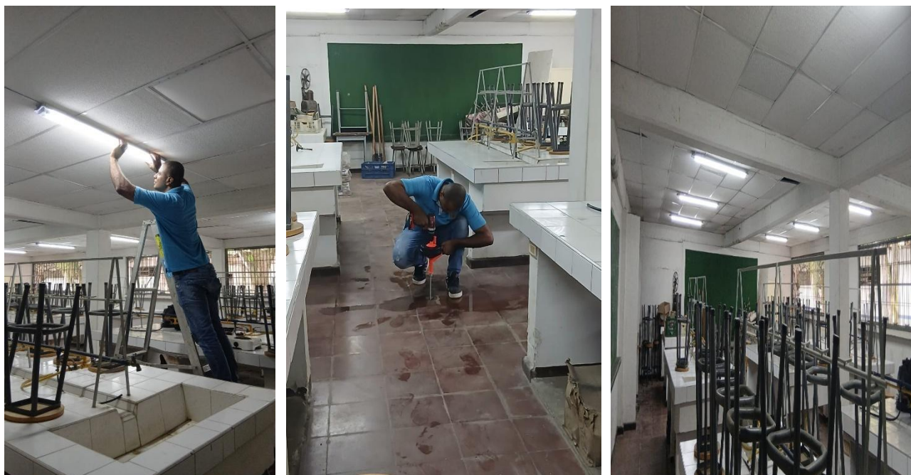
Cambio iluminación, destape de sifones, revisión del sistema eléctrico laboratorio de química
