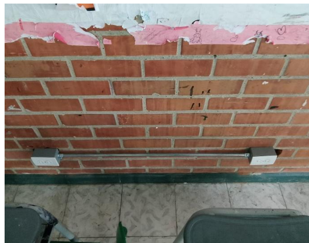
Cambio y mejoramiento de tomas sala de sistemas john f Kennedy
